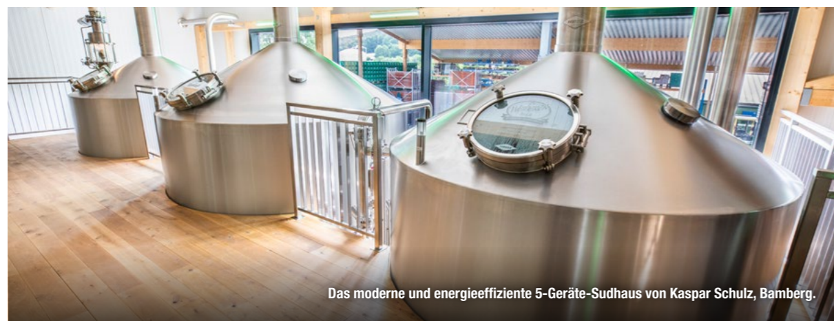
Der Sudhaus-Neubau, Fertigstellung Mai 2020.
